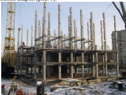
Рисунок 1. Конструкция сборно-монолитного здания
